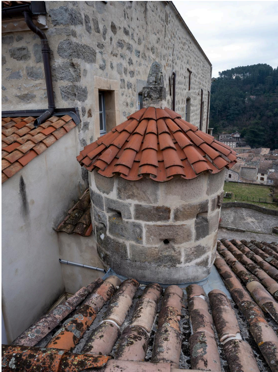
Tourelle d'escalier sud-ouest, depuis l'ouest
