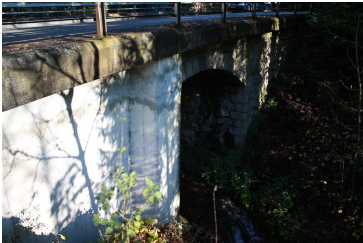
Pont du Martelet, face aval
