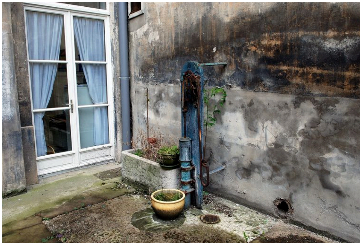
Cour fermée par la chapelle et la maison : pompe et bassin
