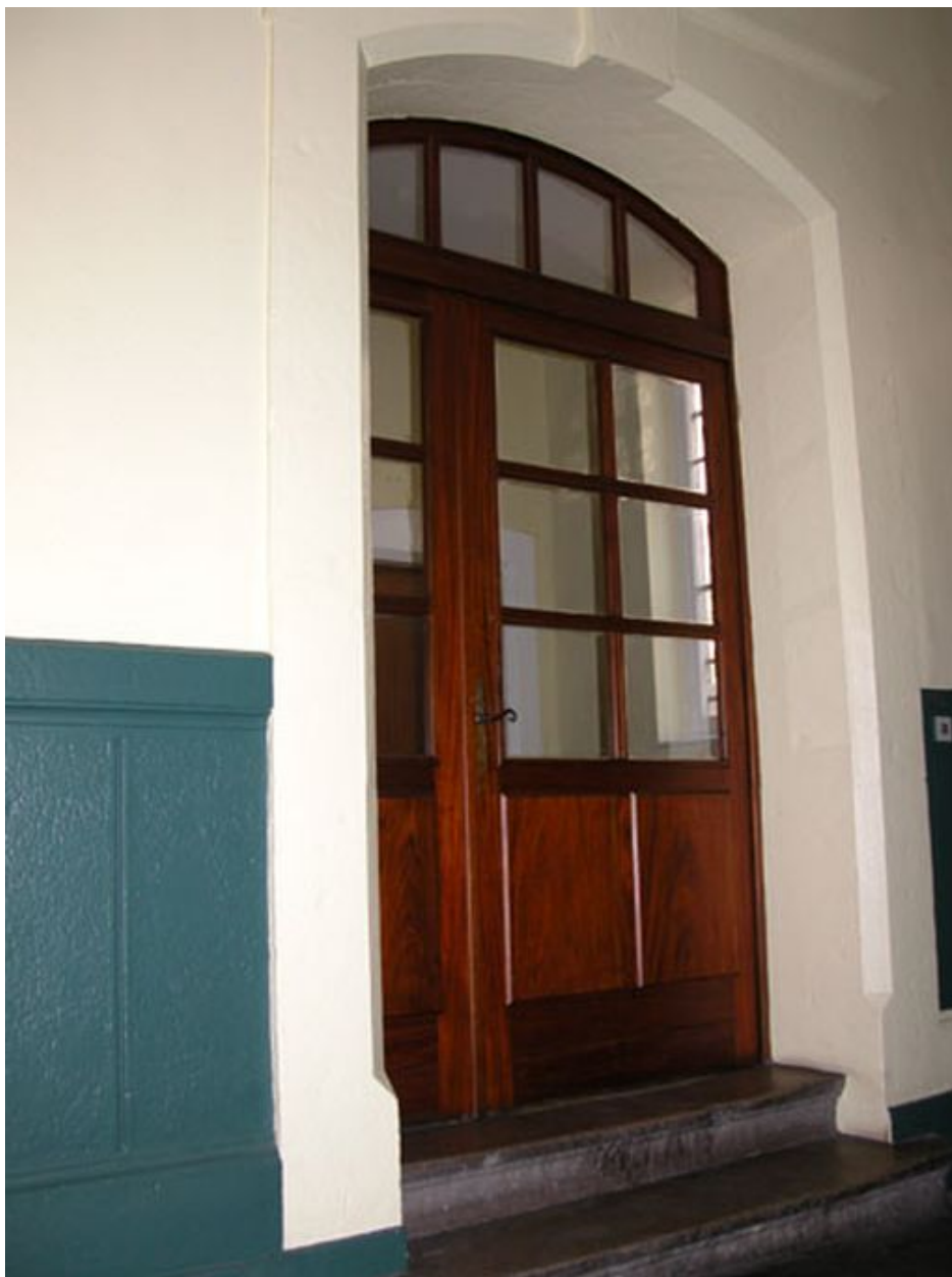
Porte d'accès à l'escalier
