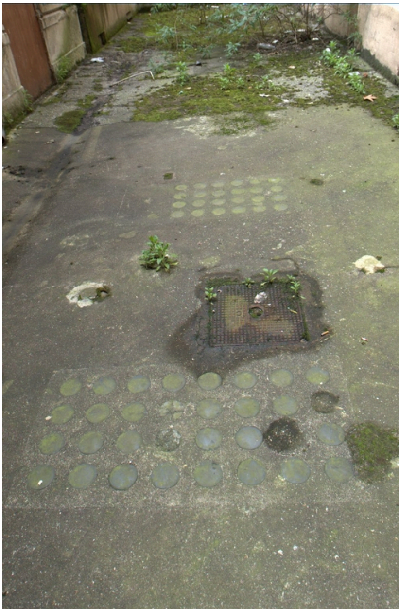
Détail plaques de verre circulaires extérieures éclairant le sous-sol
