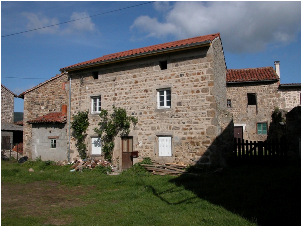
Vue d'ensemble du logis, depuis le nord-est.
