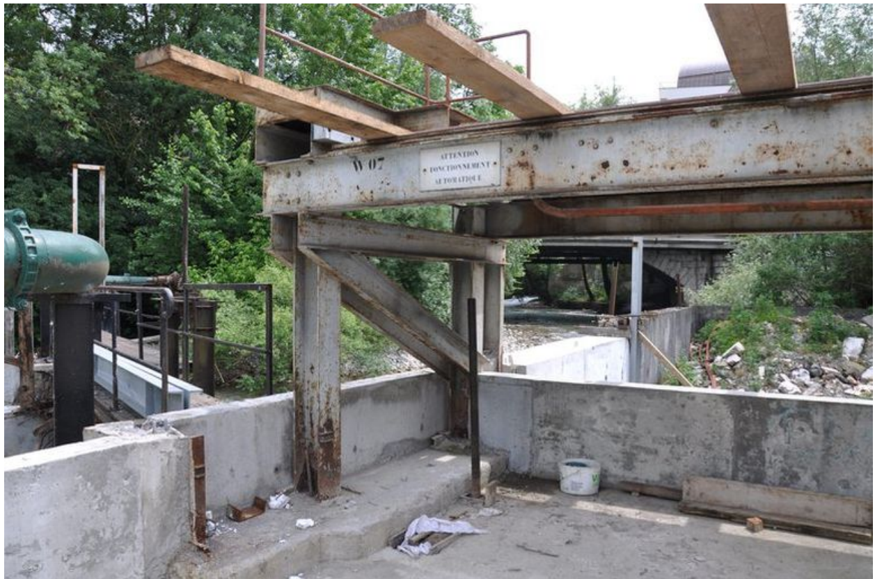
Ancienne prise d'eau
