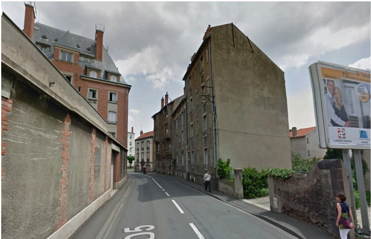
Immeubles détruits sur l'avenue Pasteur (à droite). Avant la construction d'une résidence.
