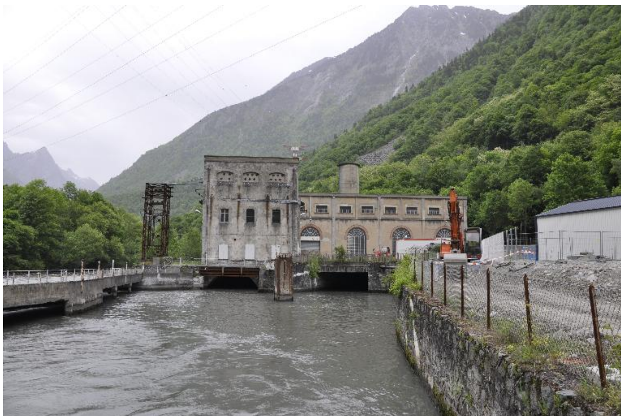
Vue des bâtiments de la centrale et des pylones
