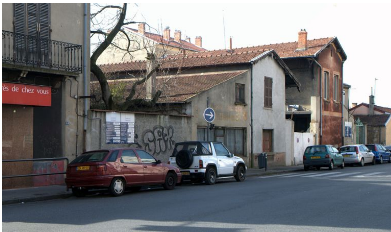
Vue du 154 route de Genas depuis le nord-est
