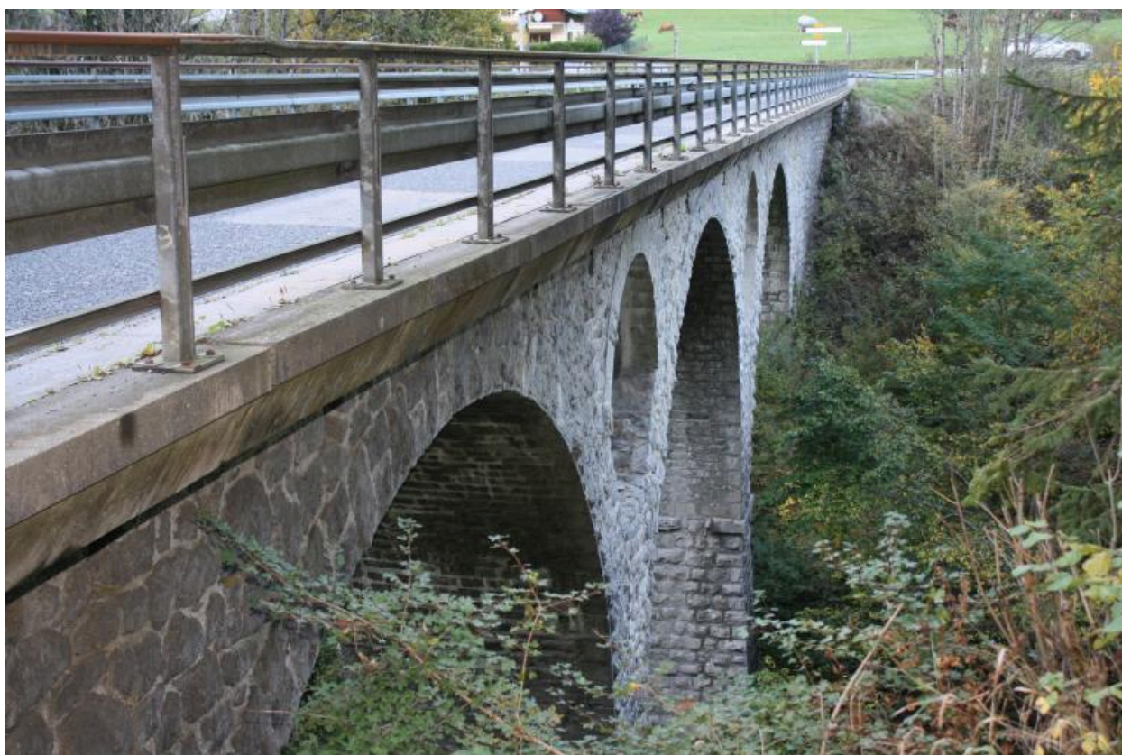
Pont de la Tassonnière, face amont
