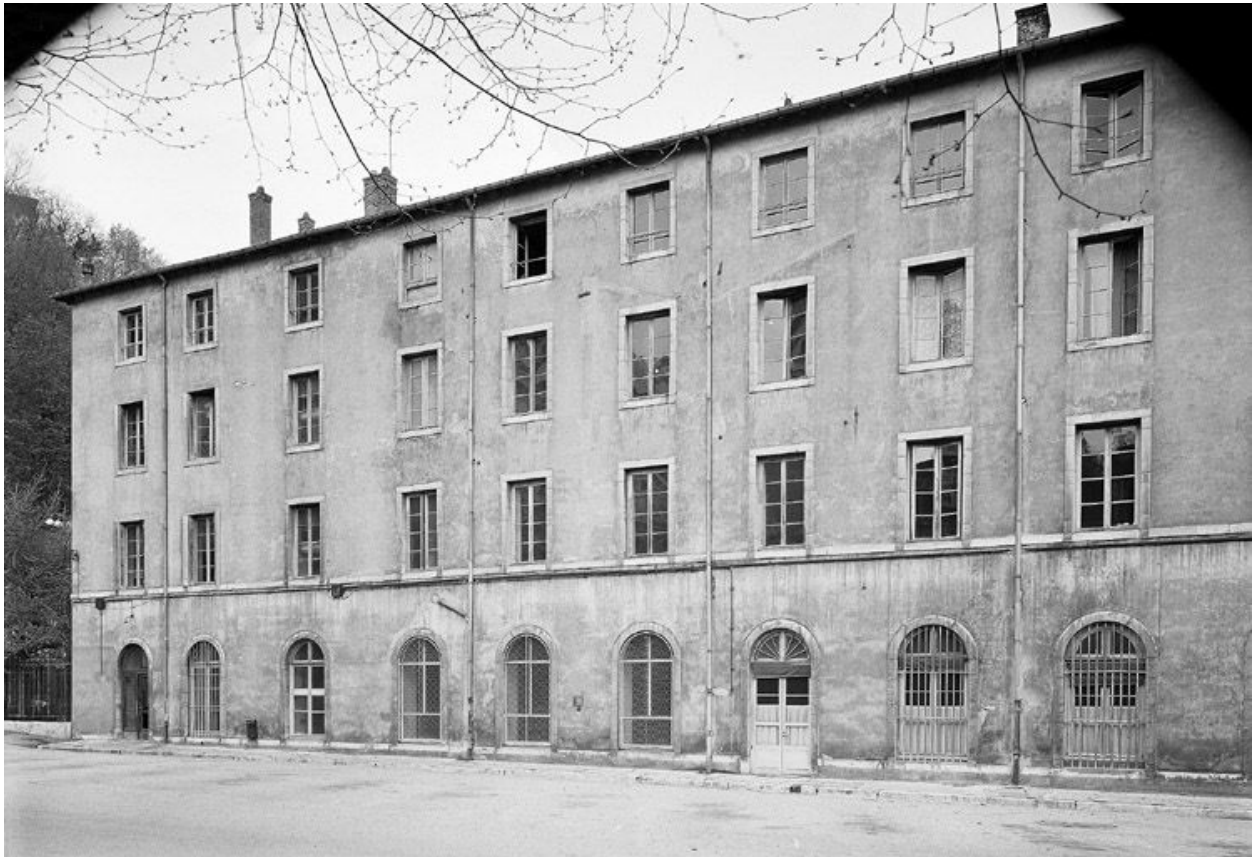
Aile sud, façade sur cour secondaire
