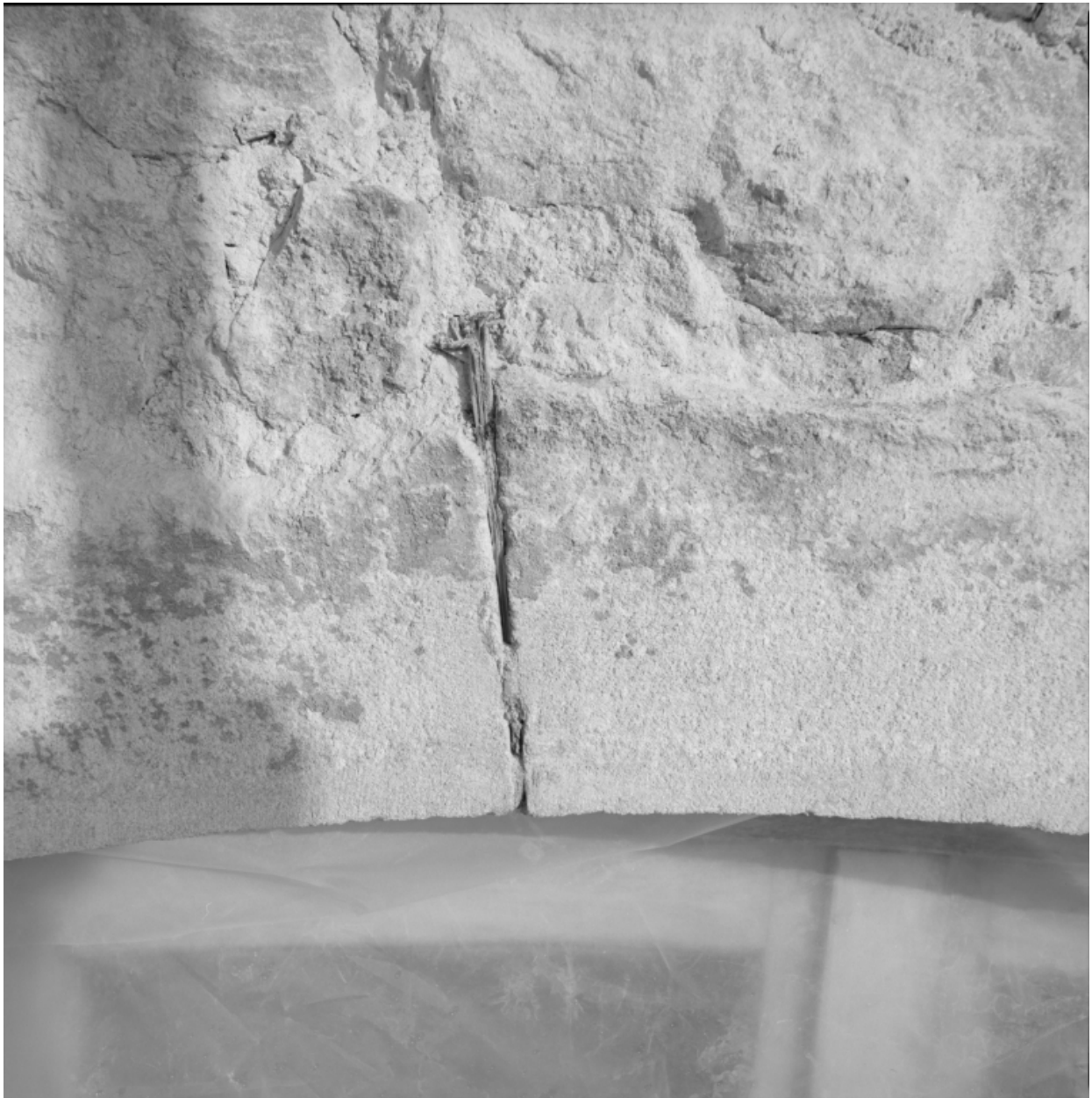
Etude archéologique de la façade principale : niveau 2. Fenêtre XVIII e siècle, détail d'un couvrement en arc segmentaire : cale en bois entre deux claveaux (f).
