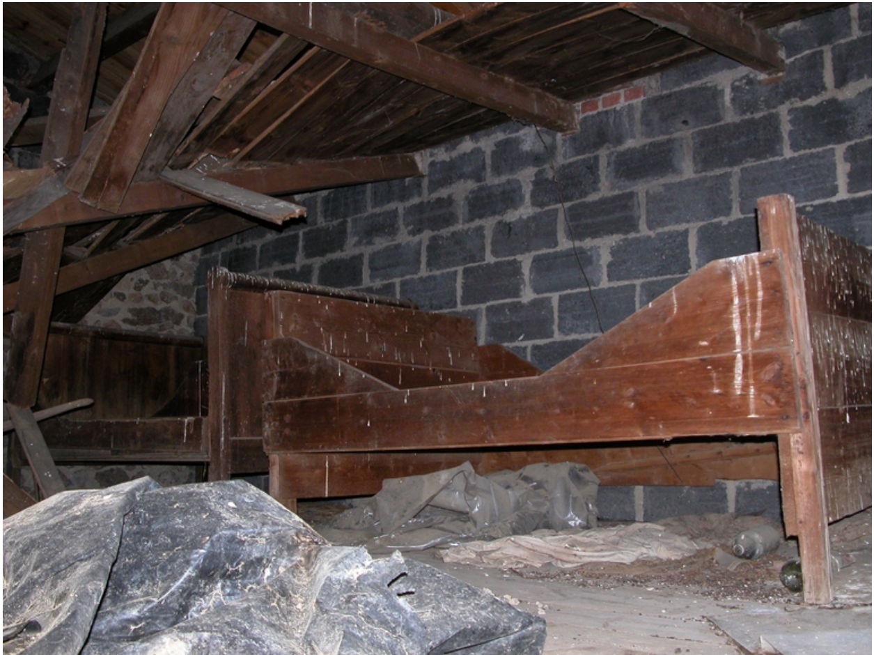
Vue intérieure de l'étage.
