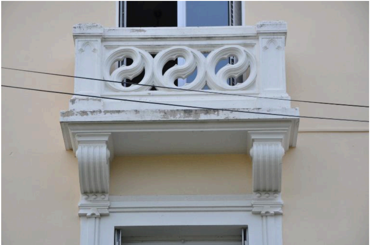
Balcon en ciment moulé au 1er étage de la façade principale
