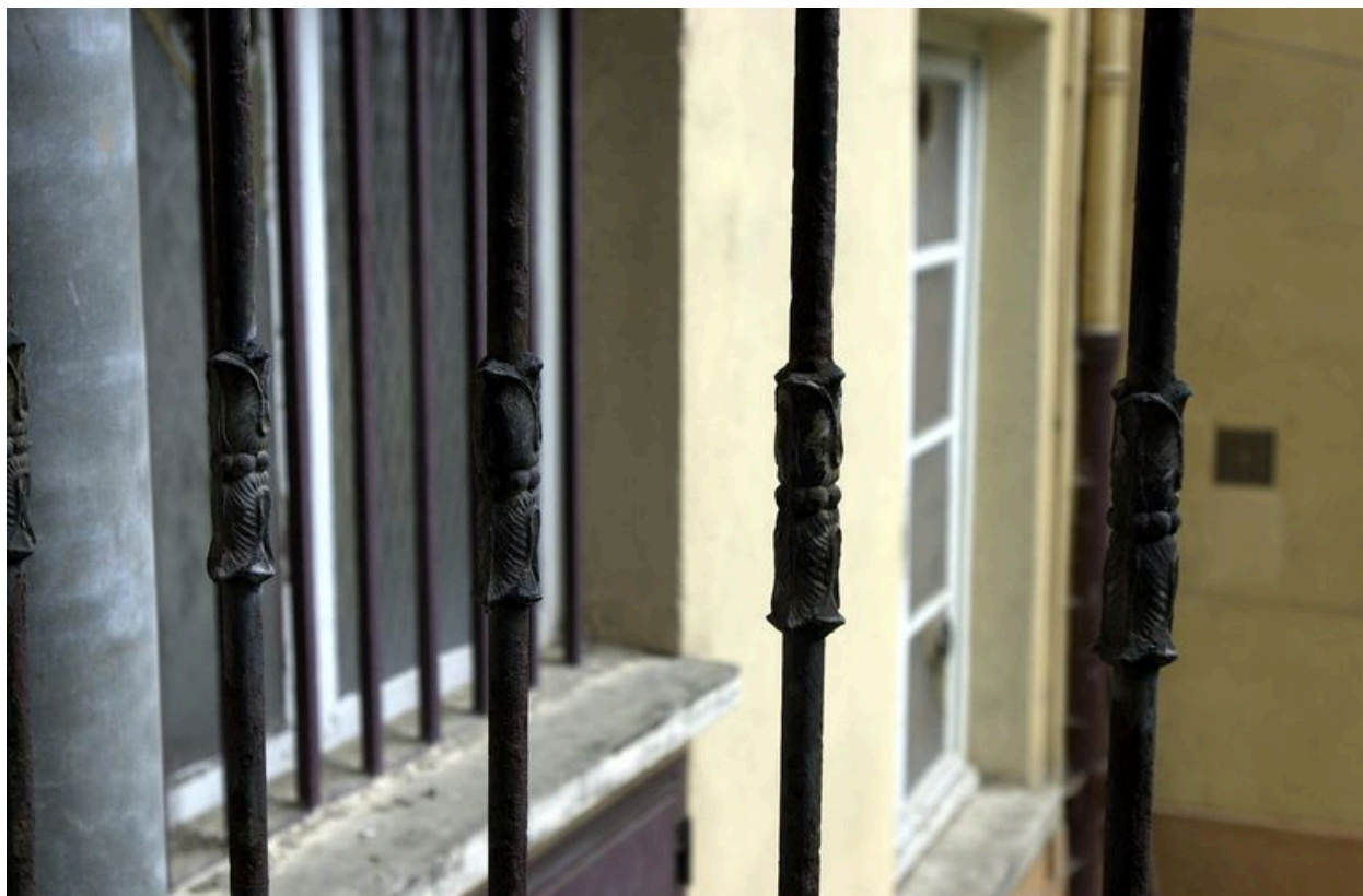
Détail du garde-corps du premier repos
