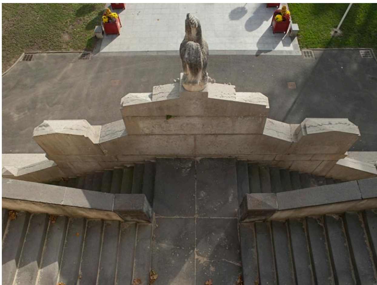
Les volées doubles de l'escalier du monument, vues depuis le haut.
