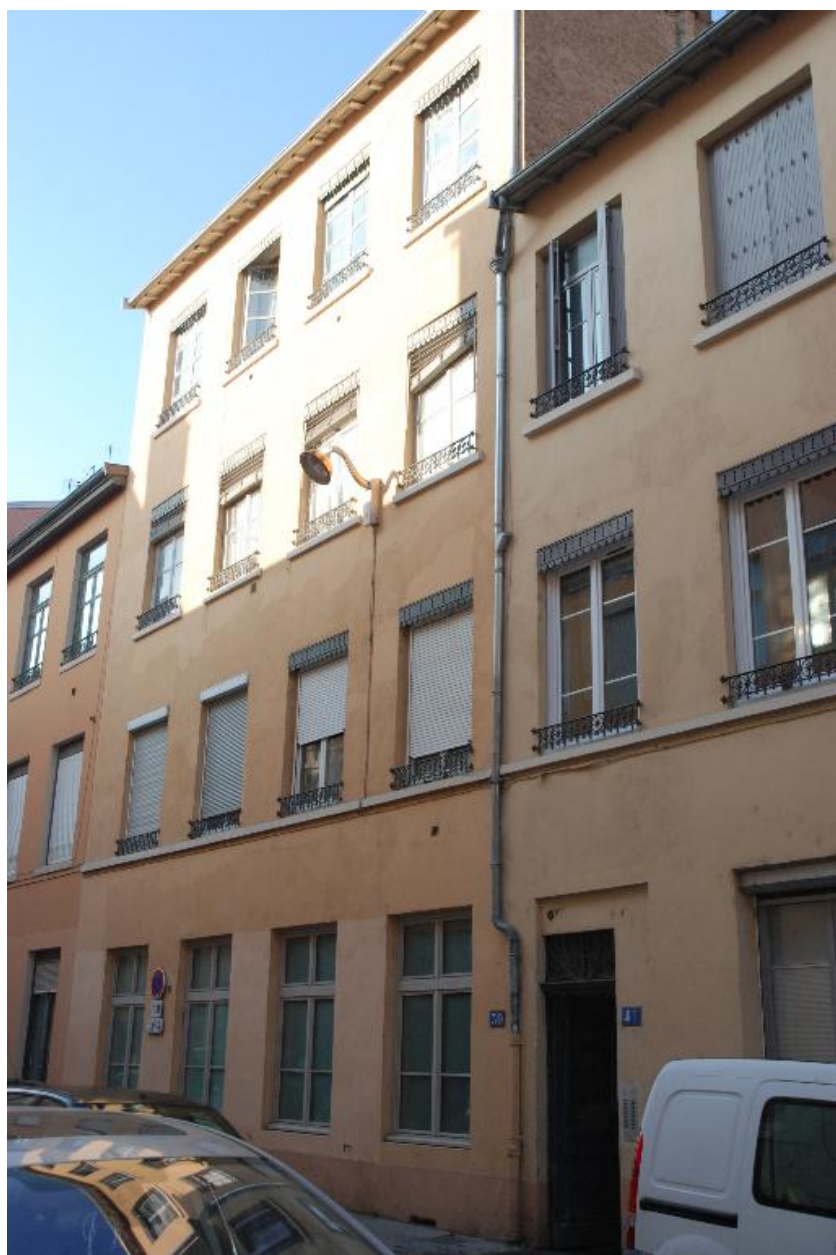
Vue d'ensemble nord est
