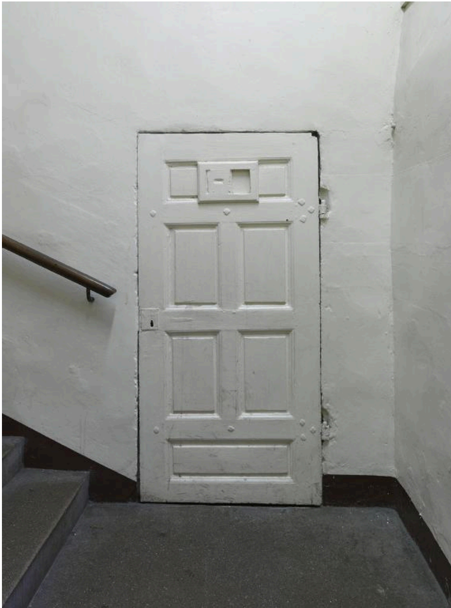
Escalier F, 1er repos : porte ancienne
