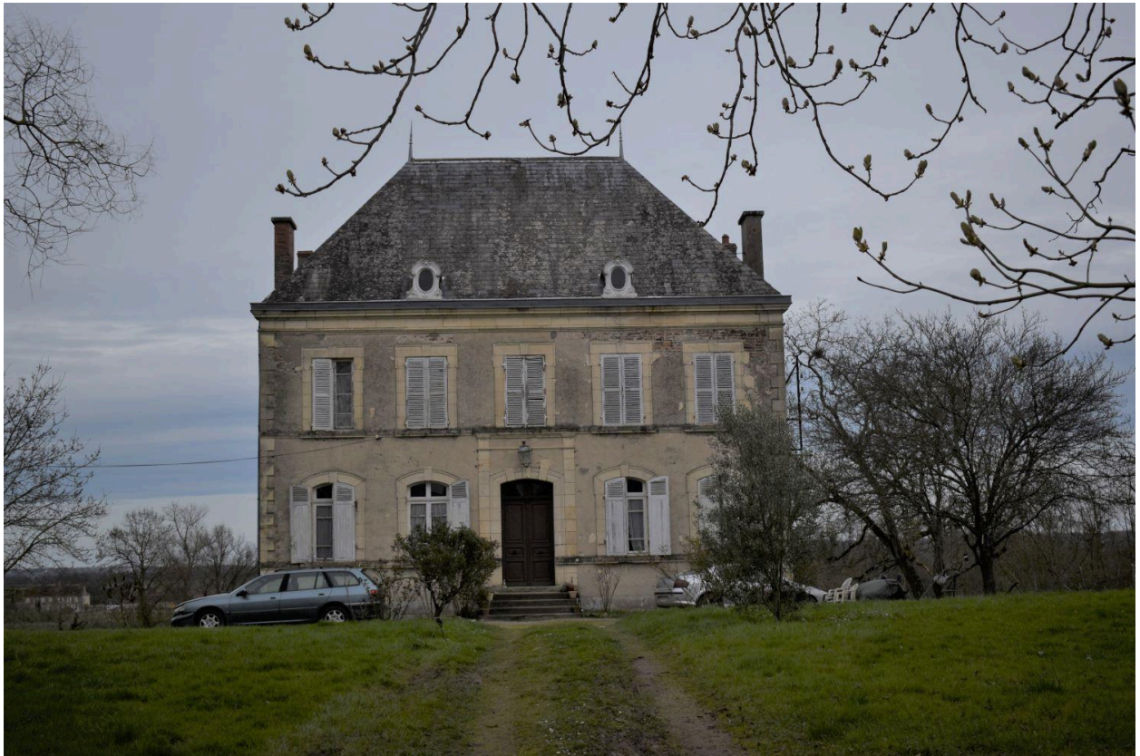
Vue de la maison de maître.
