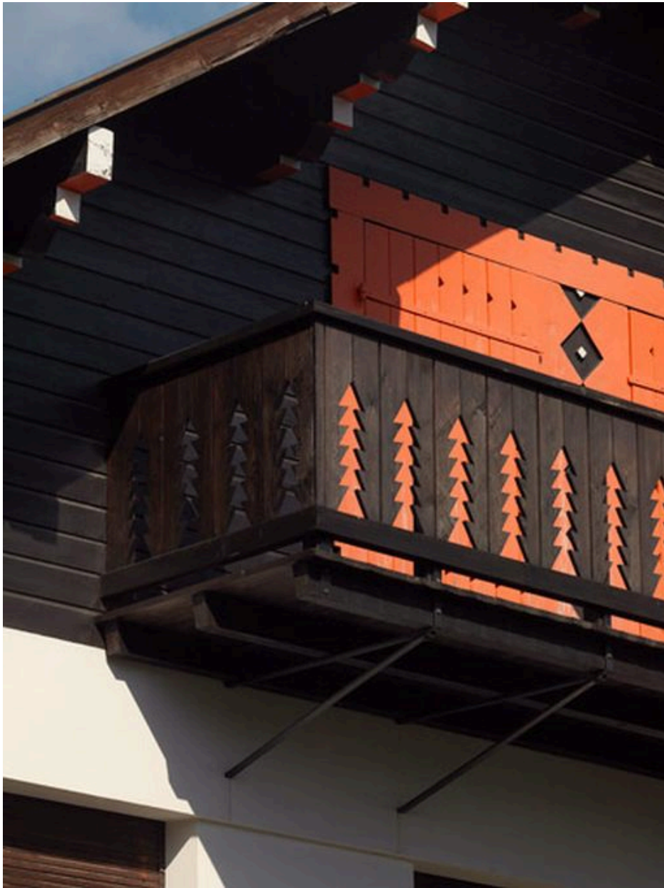
Chalet la Chaumette, 31 route du Téléphérique. Etage de comble. Détail du balcon
