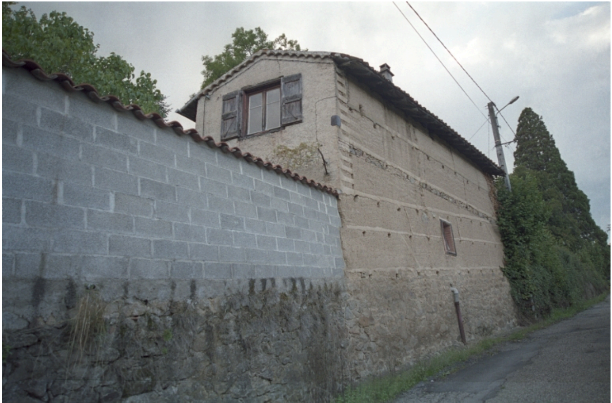
La Font Fort, bâtiment agricole en pisé (1986 B1 391). Vue d'ensemble de la façade arrière du bâtiment depuis la route.
