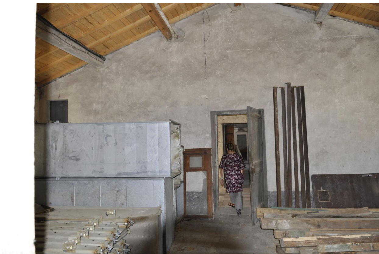
Comble (vue d'intérieur)
