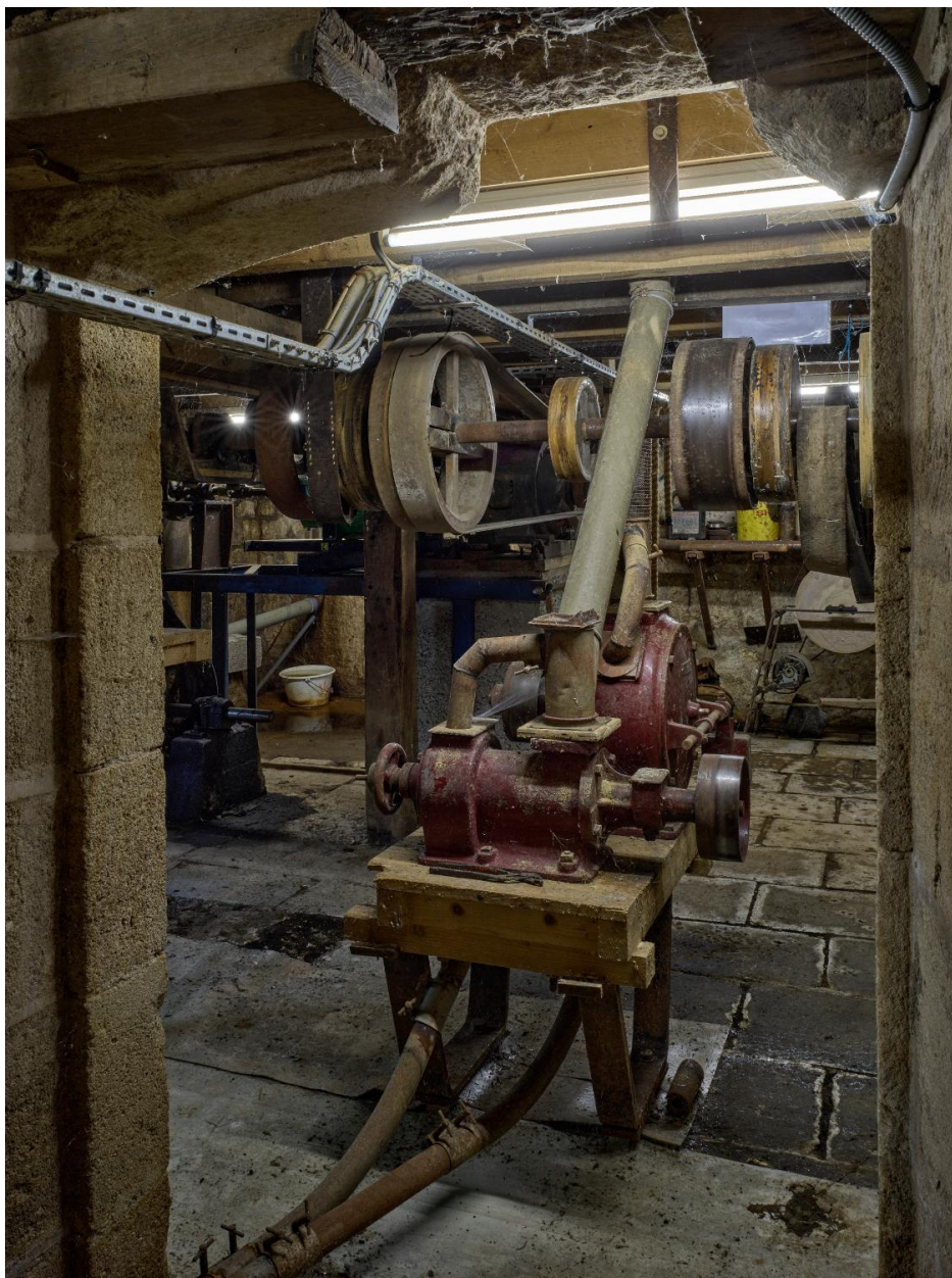
Sous-sol : Vue générale des éléments moteurs et de transmission.
