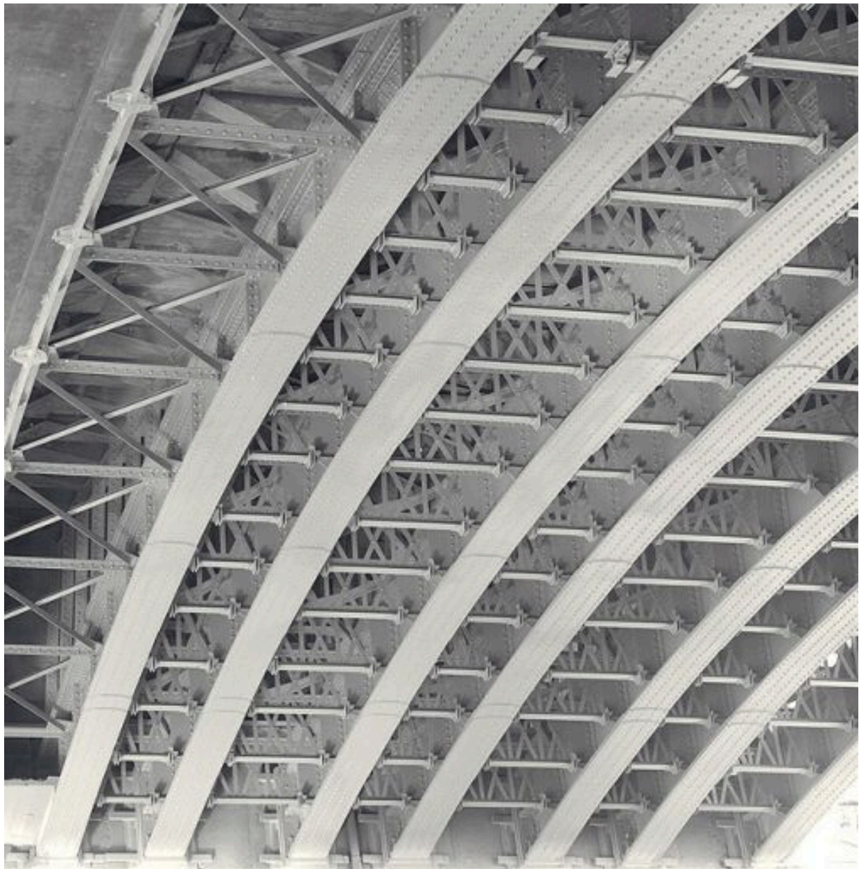
Détail du dessous des arches
