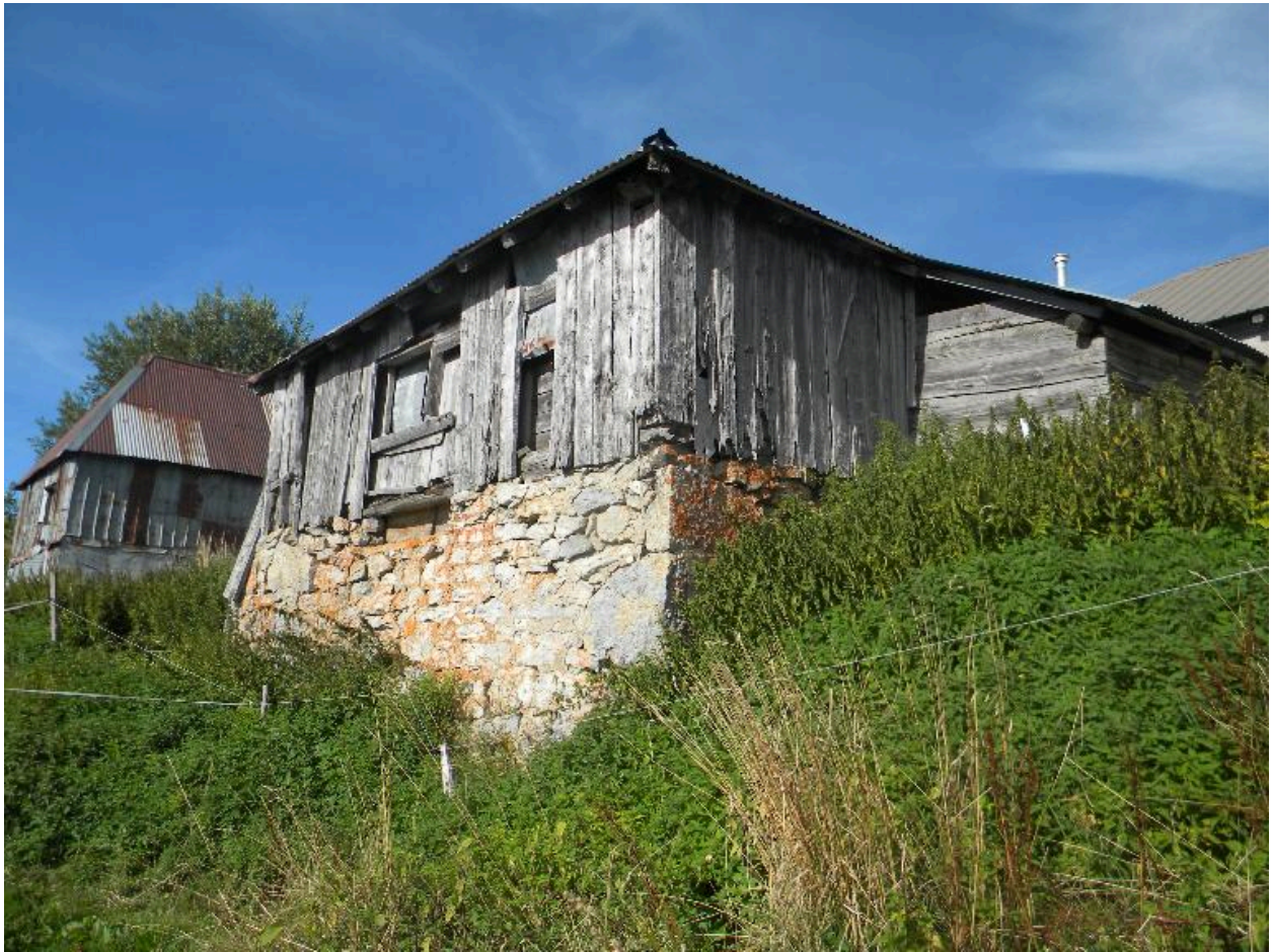
Vue de trois-quarts sud-ouest de l'ancienne étable.
