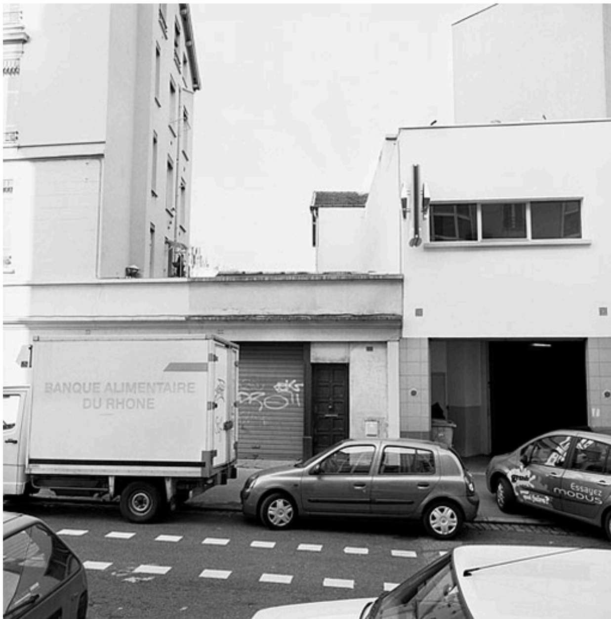
Vue est façade rue Rachais
