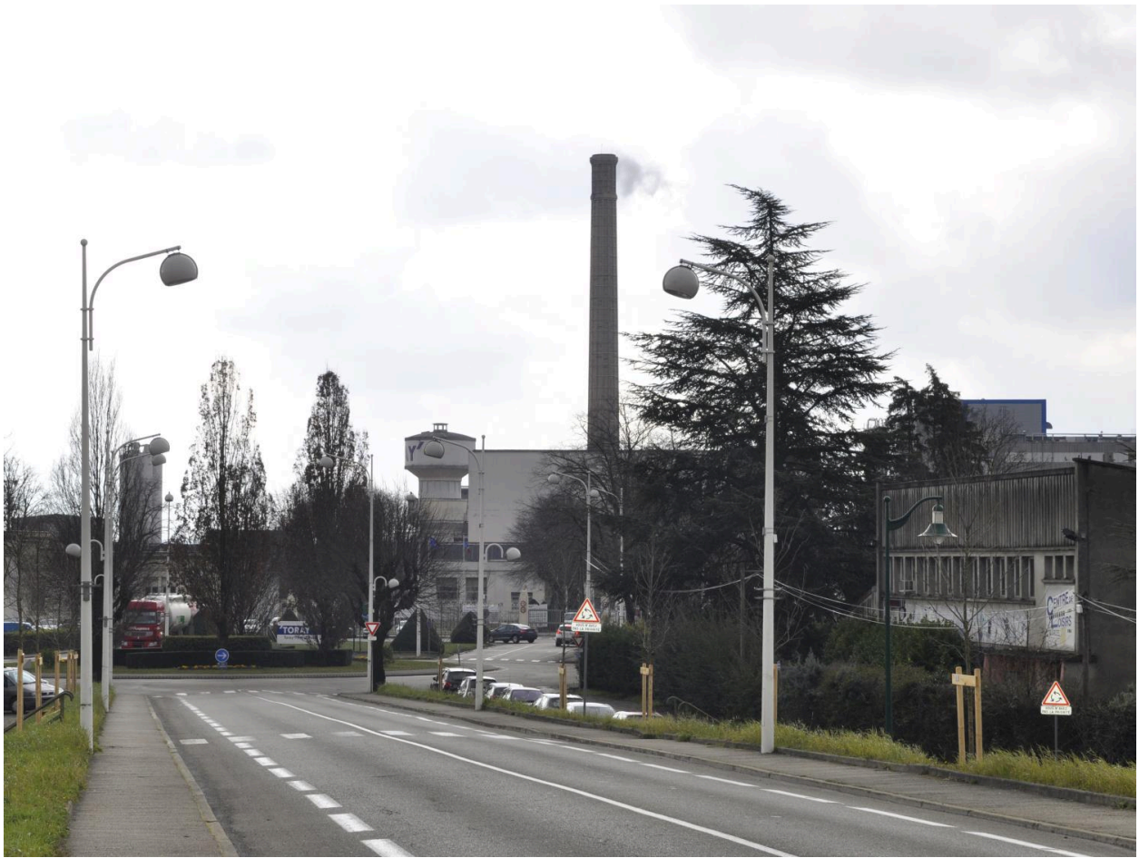
Vue des éléments hauts de l'usine
