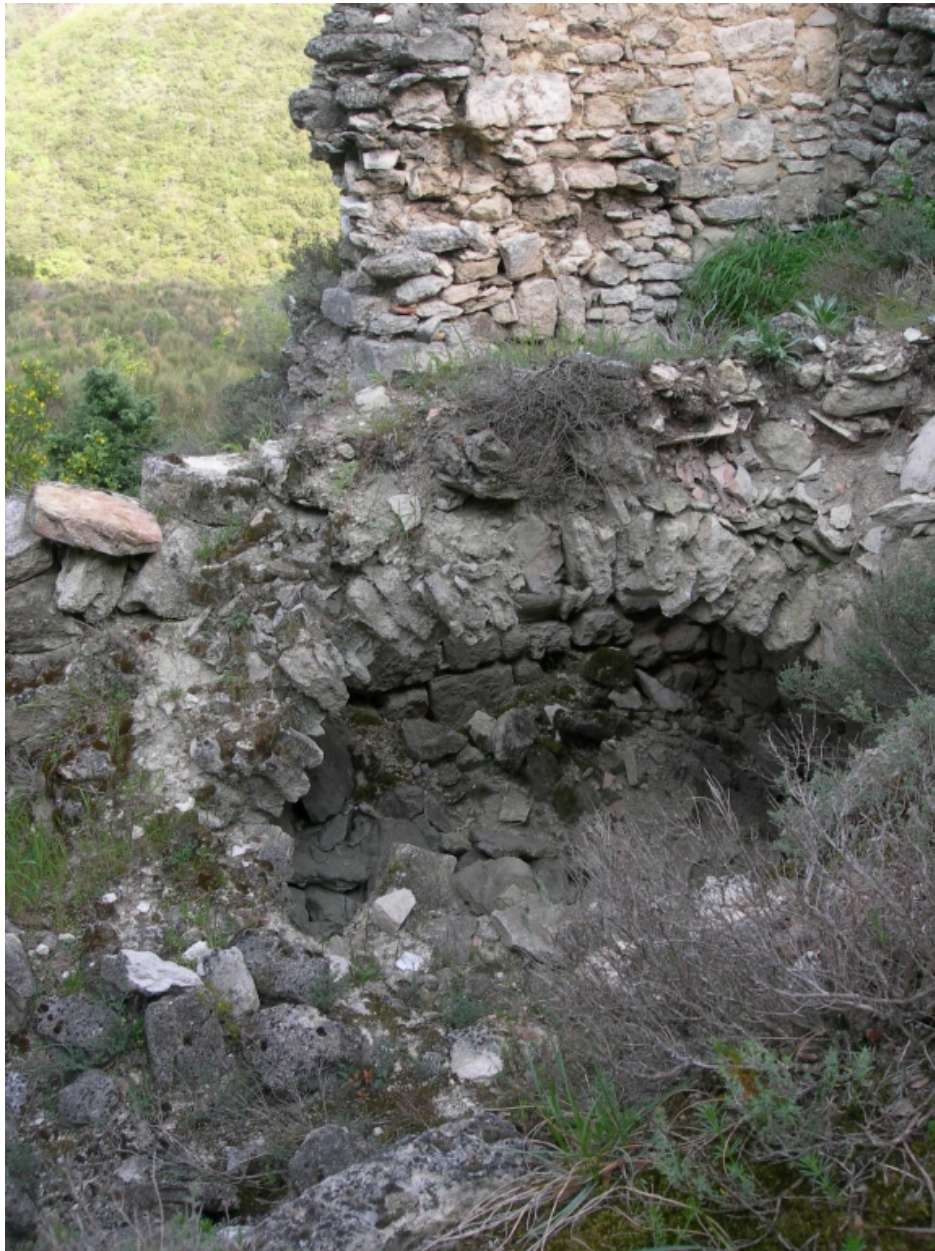
La Viale, ancien village : détail de construction dans les ruines d'éléments fortifiés ou de logis.
