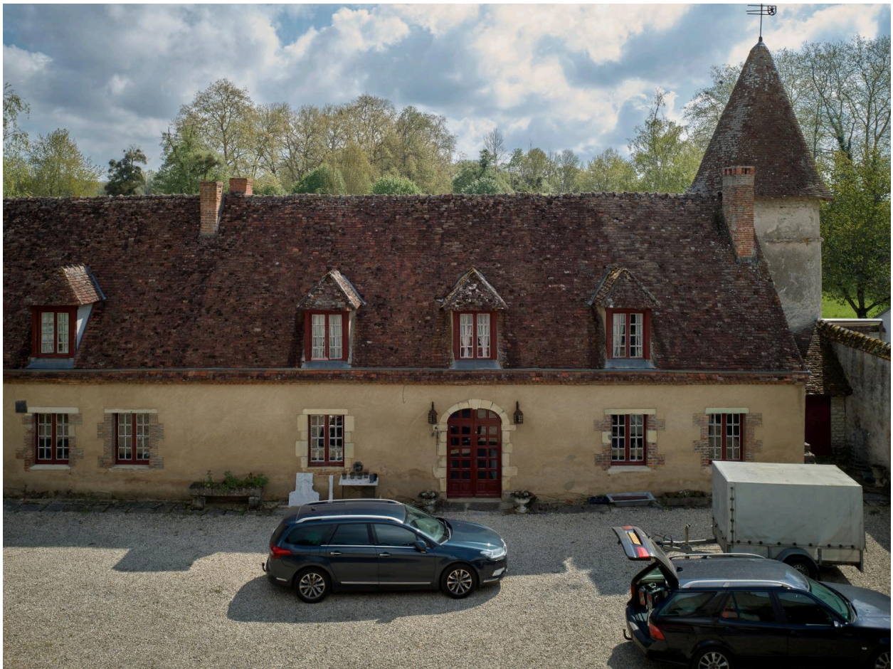
Bâtiment principal vu de l'ouest.
