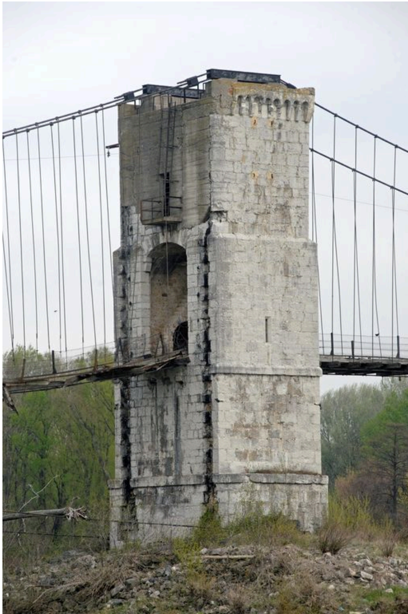
Vue de la pile centrale (de biais)
