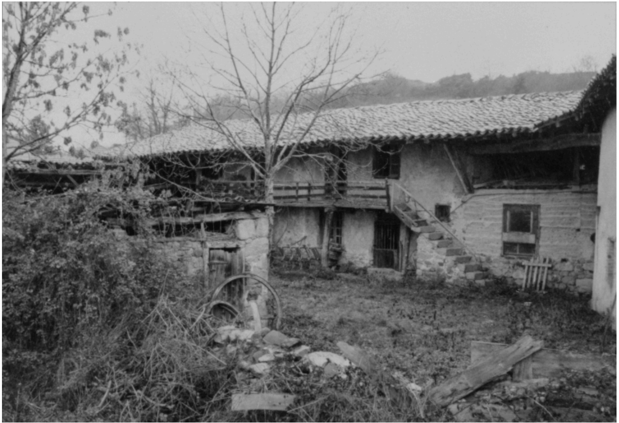
Cezay, la Vialle (1987 B1 1163), type A1. Vue d'ensemble du logis de trois-quarts gauche.
