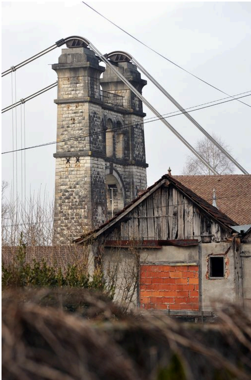
Pylône droit, face amont, vue générale (depuis la rive droite)
