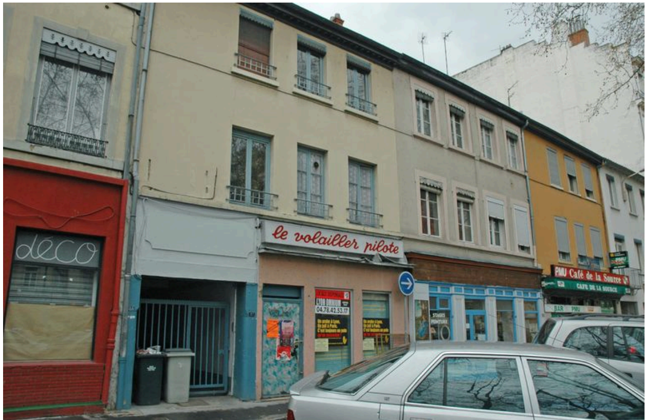
Façade sur la rue Claude-Boyer vue depuis le nord-ouest
