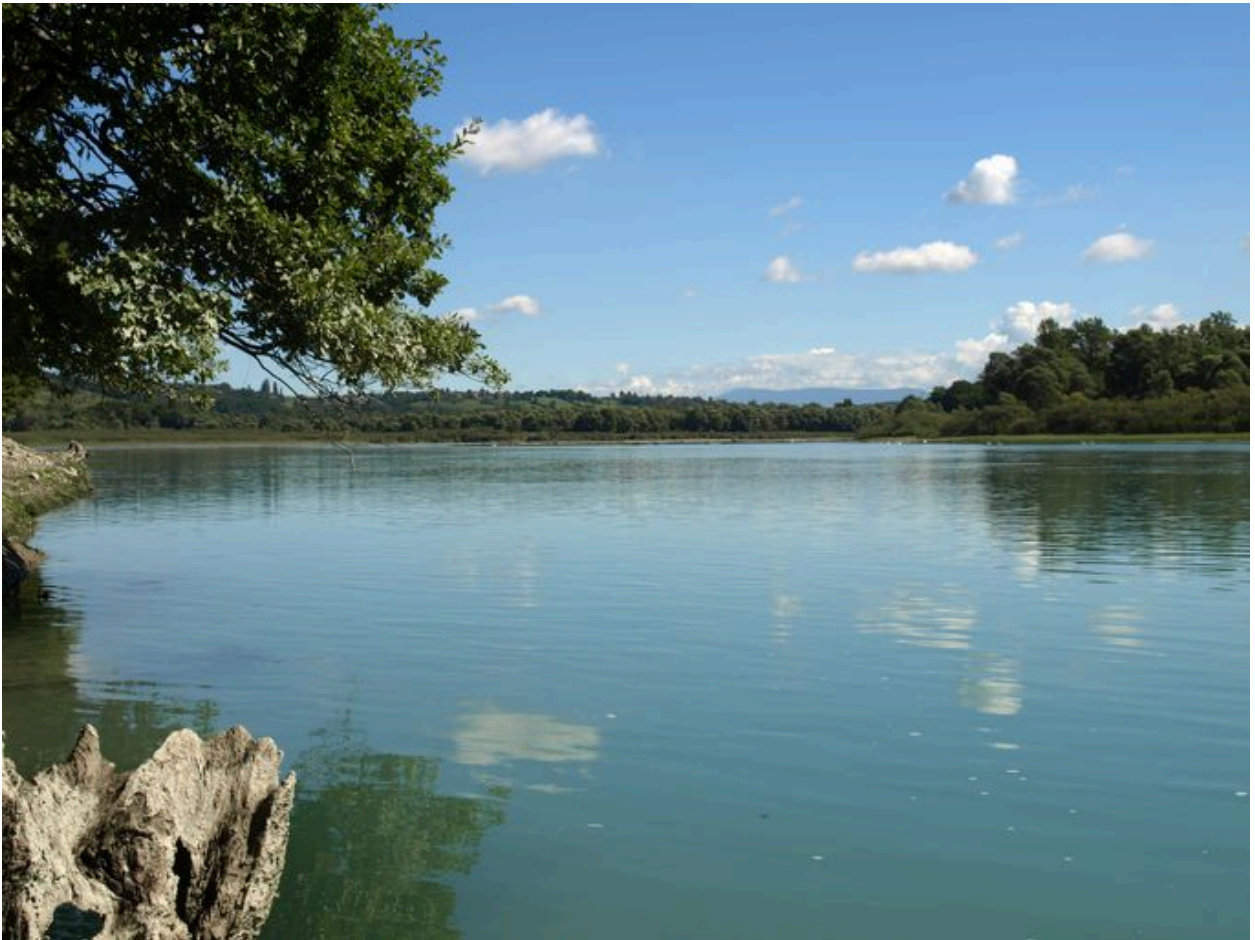
Vue du site à l'amont du pont Carnot (depuis la rive droite, vers l'amont)
