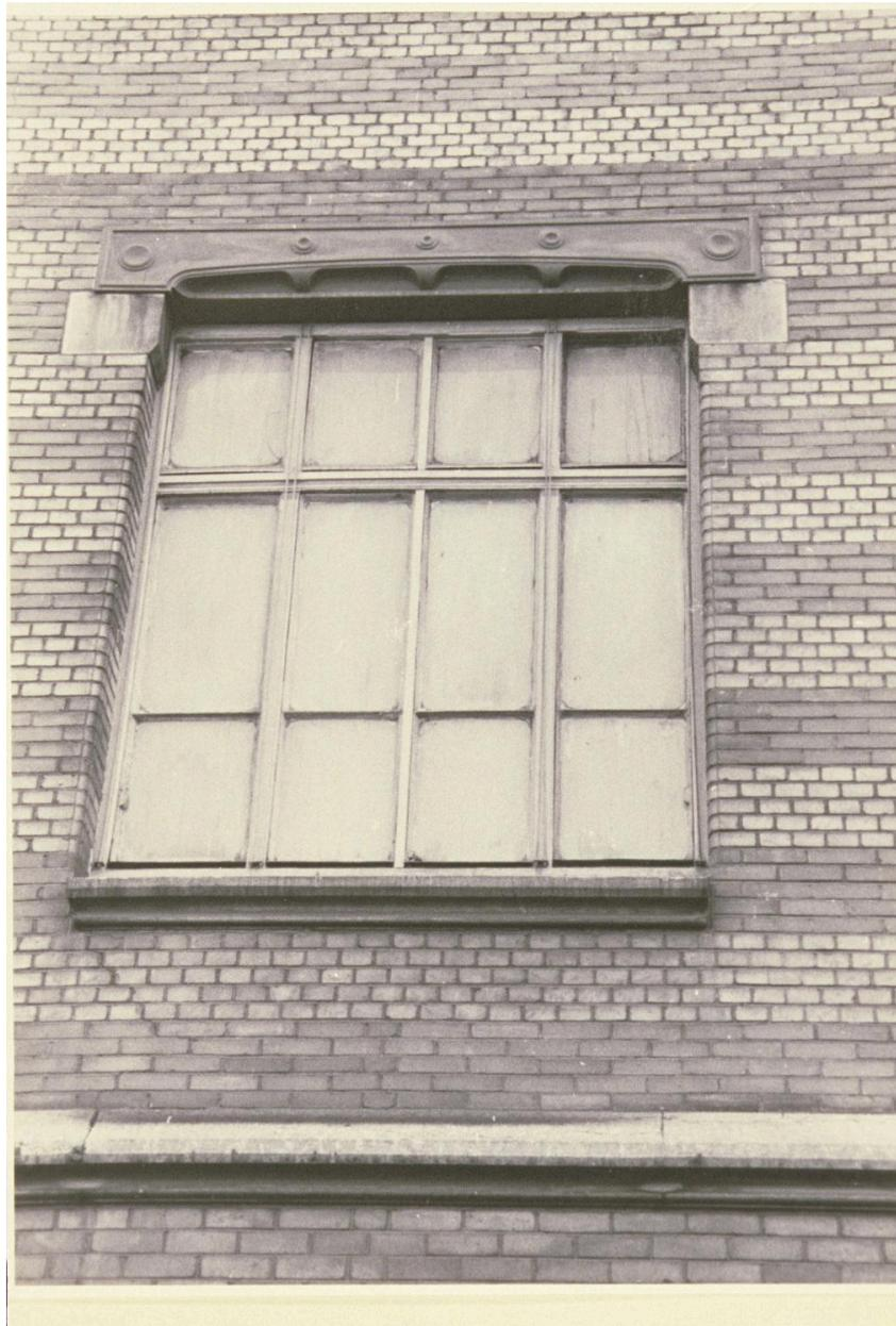
Fenêtre en chêne; châssis métallique. Linteaux en fonte de section creuse. Stores en bois.
