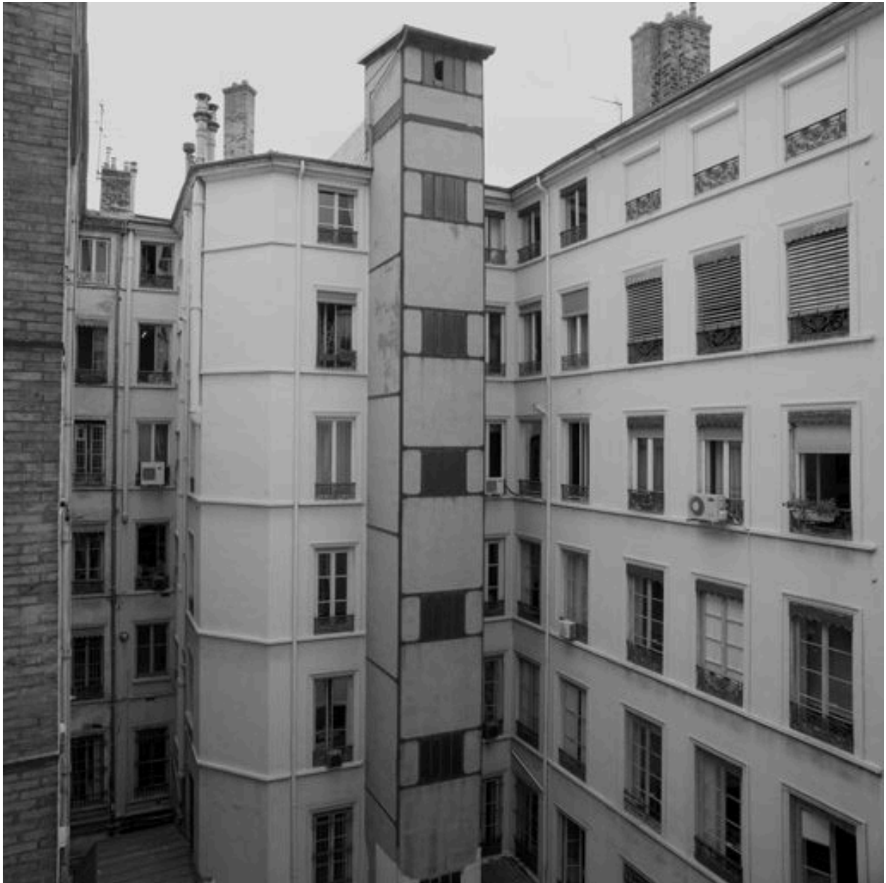
Vue du monte-charge Otis construit contre l'élévation sud
