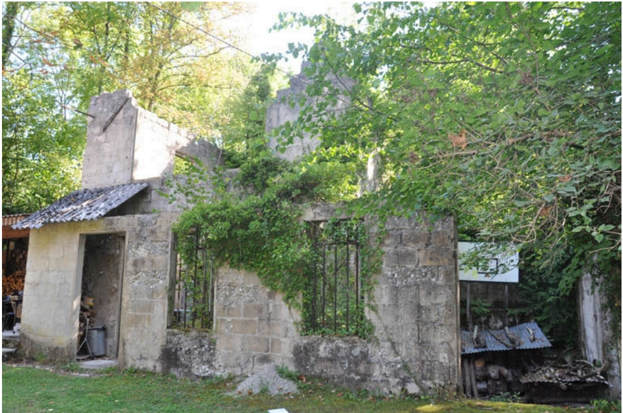
Vue de l'usine hydroélectrique, façade ouest
