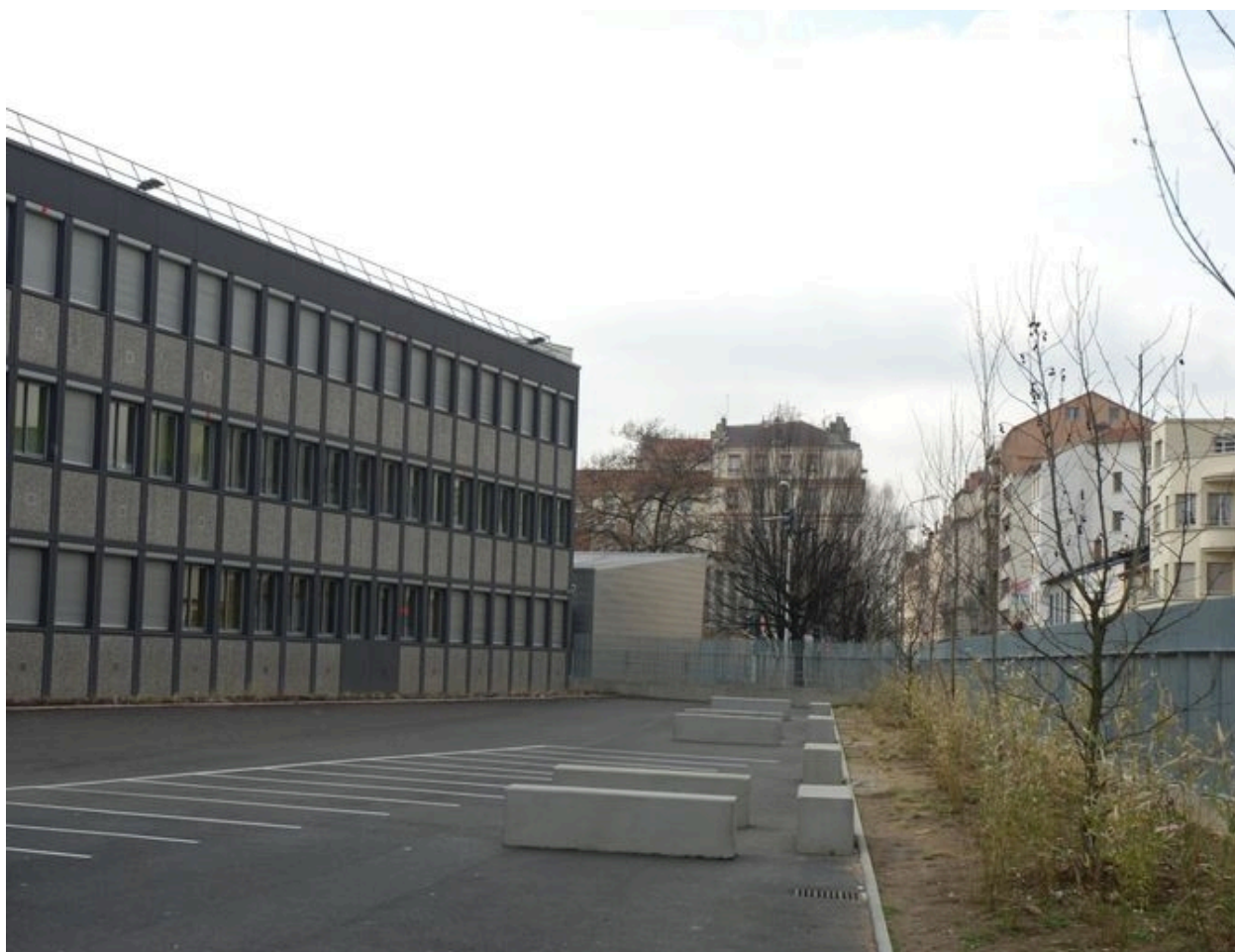
Vue de l'élévation ouest depuis la cour.
