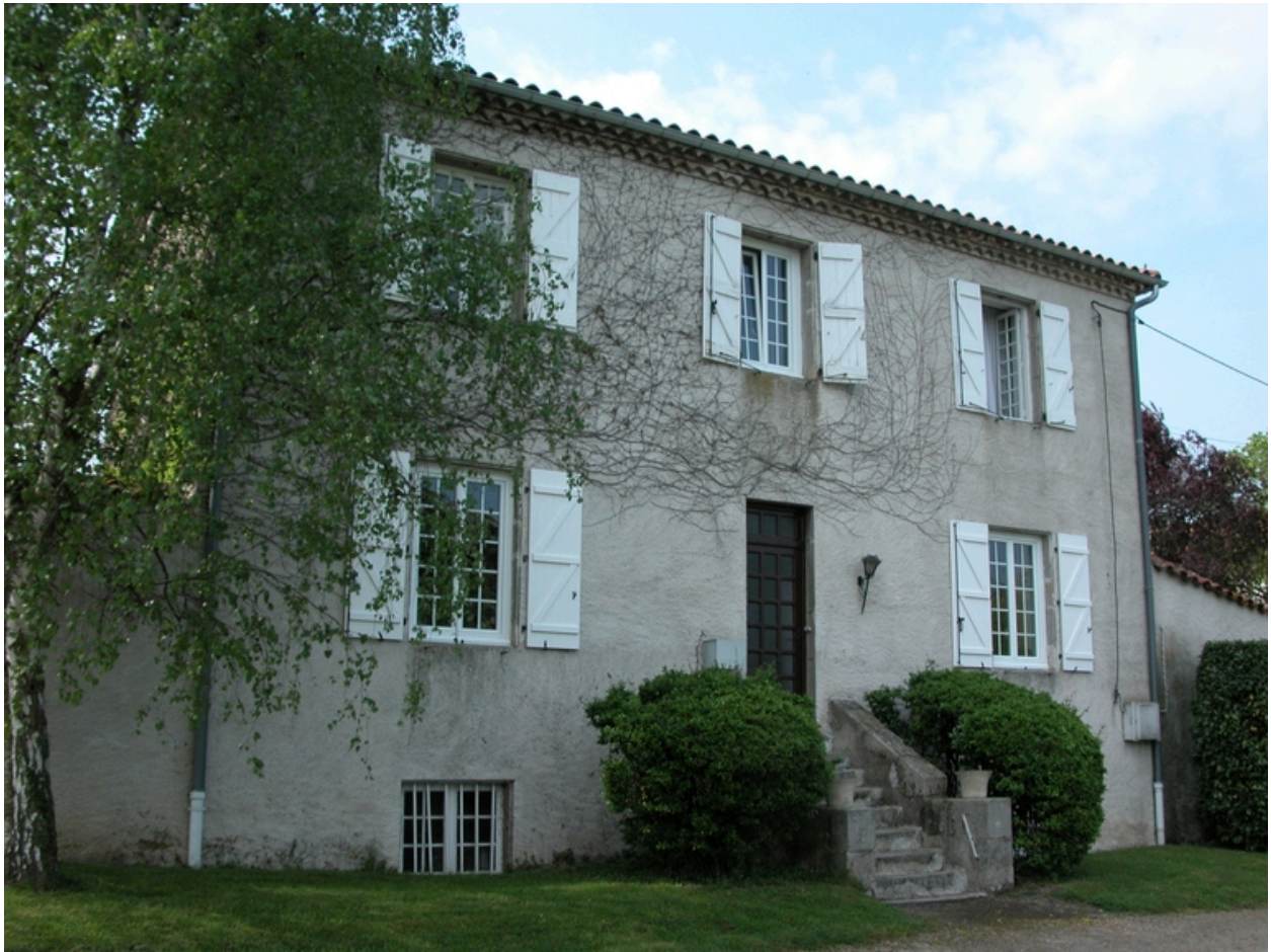
Vue du logis depuis le chemin.
