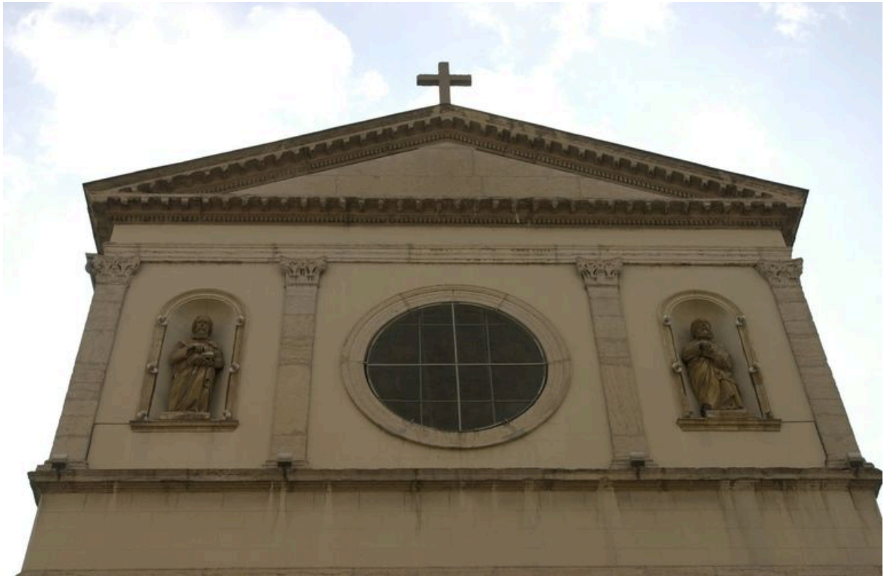
Vue du fronton de la façade principale
