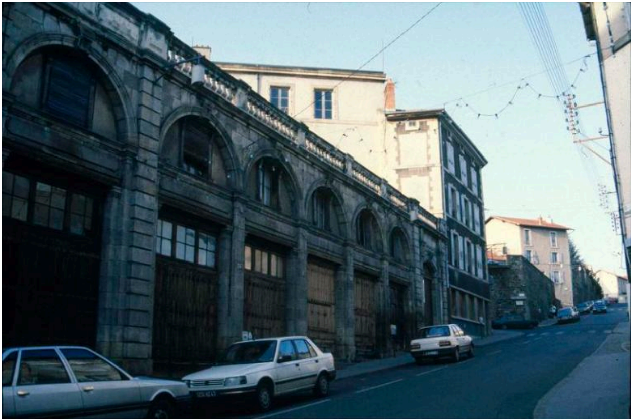
Vue des boutiques et du préau depuis le sud, avant 1990
