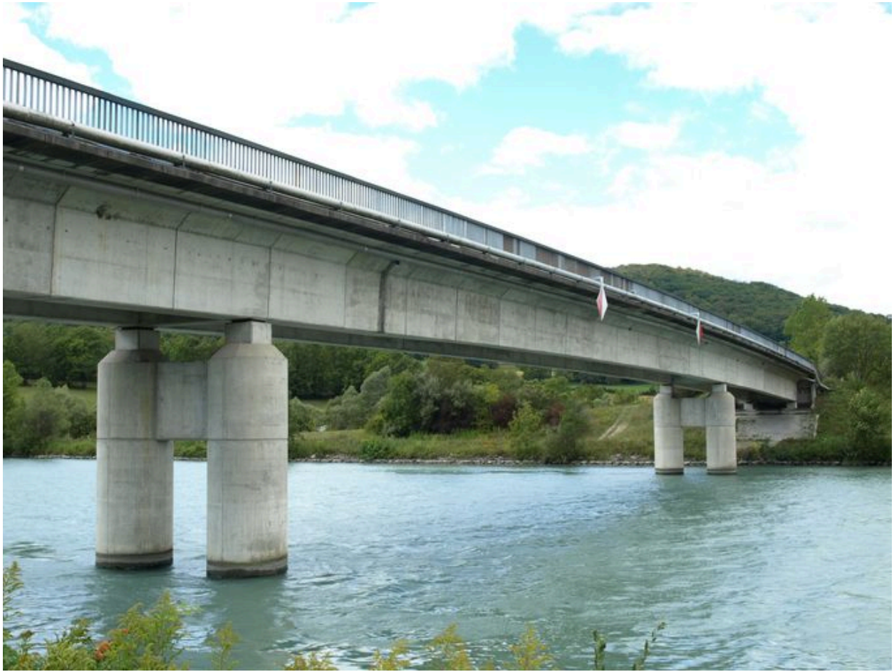
Travée centrale, face amont (depuis la rive gauche)
