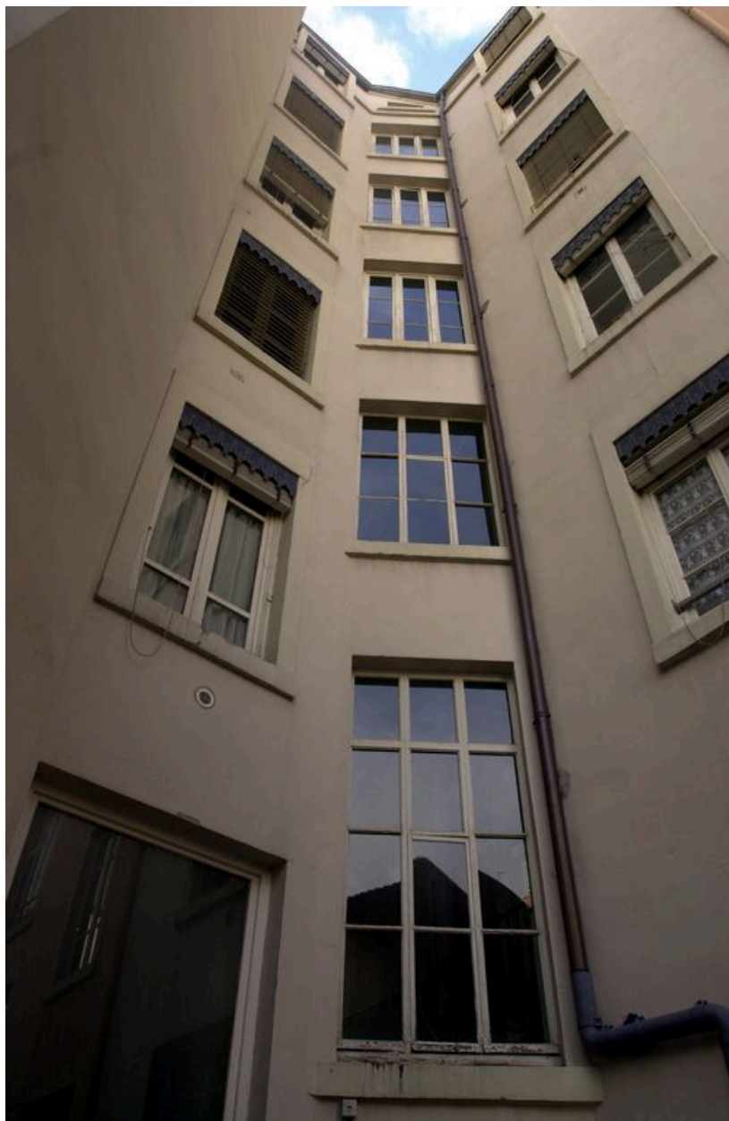
Elévations sur cour, partie supérieure. Au centre : la cage d'escalier
