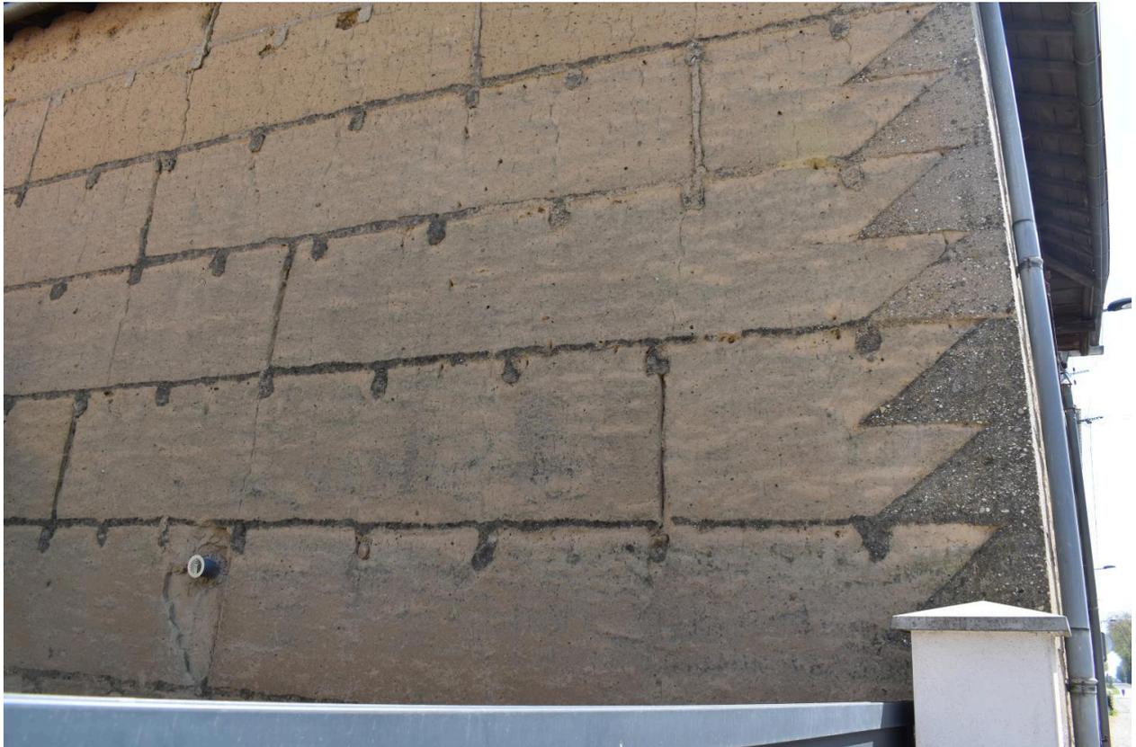
Détail : renforts d'angle béton de chaux
