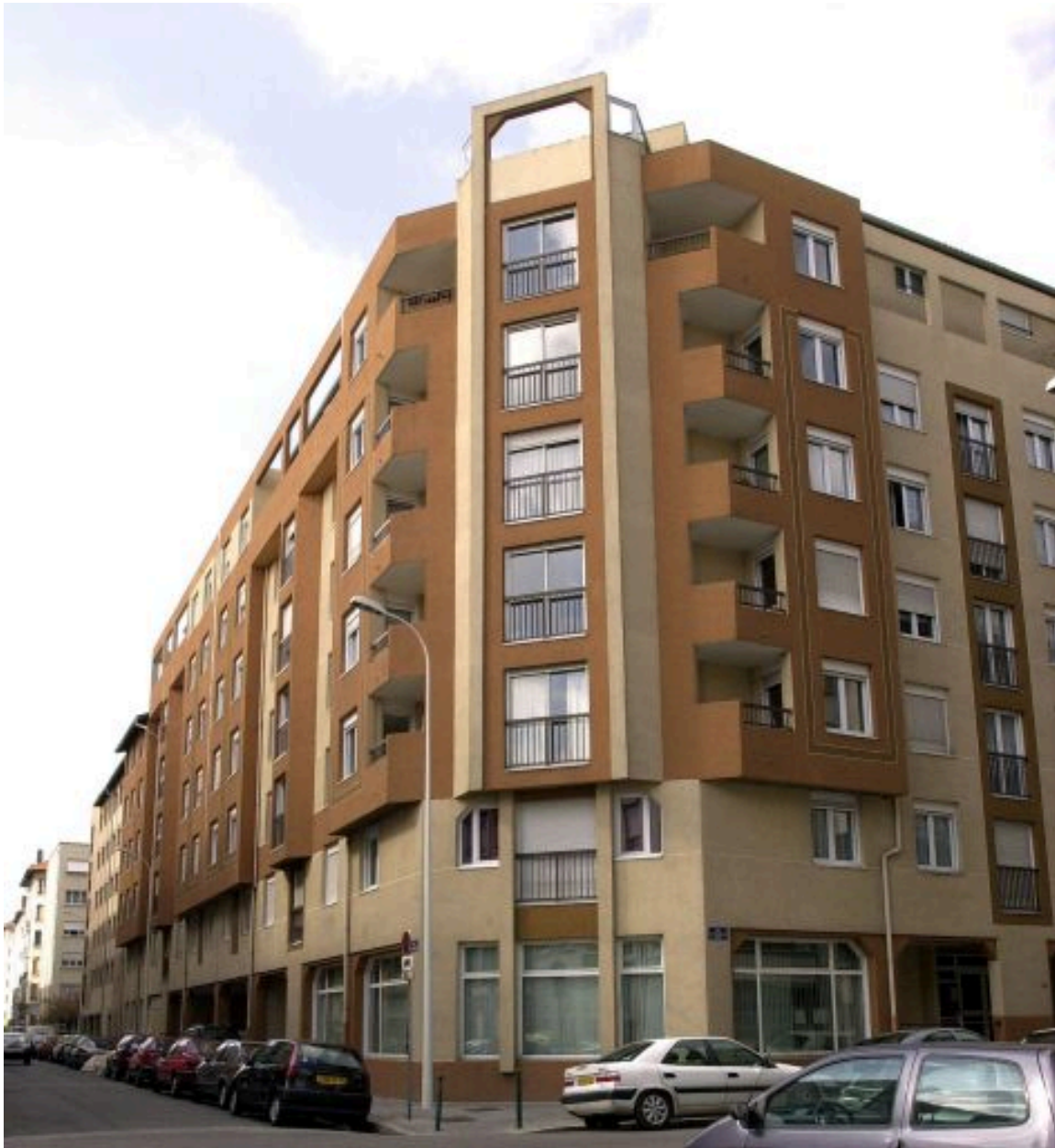
Elévation rue Delandine depuis le nord
