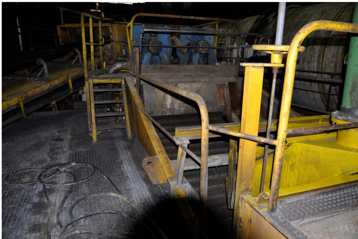
Vue de l'intérieur des ateliers
