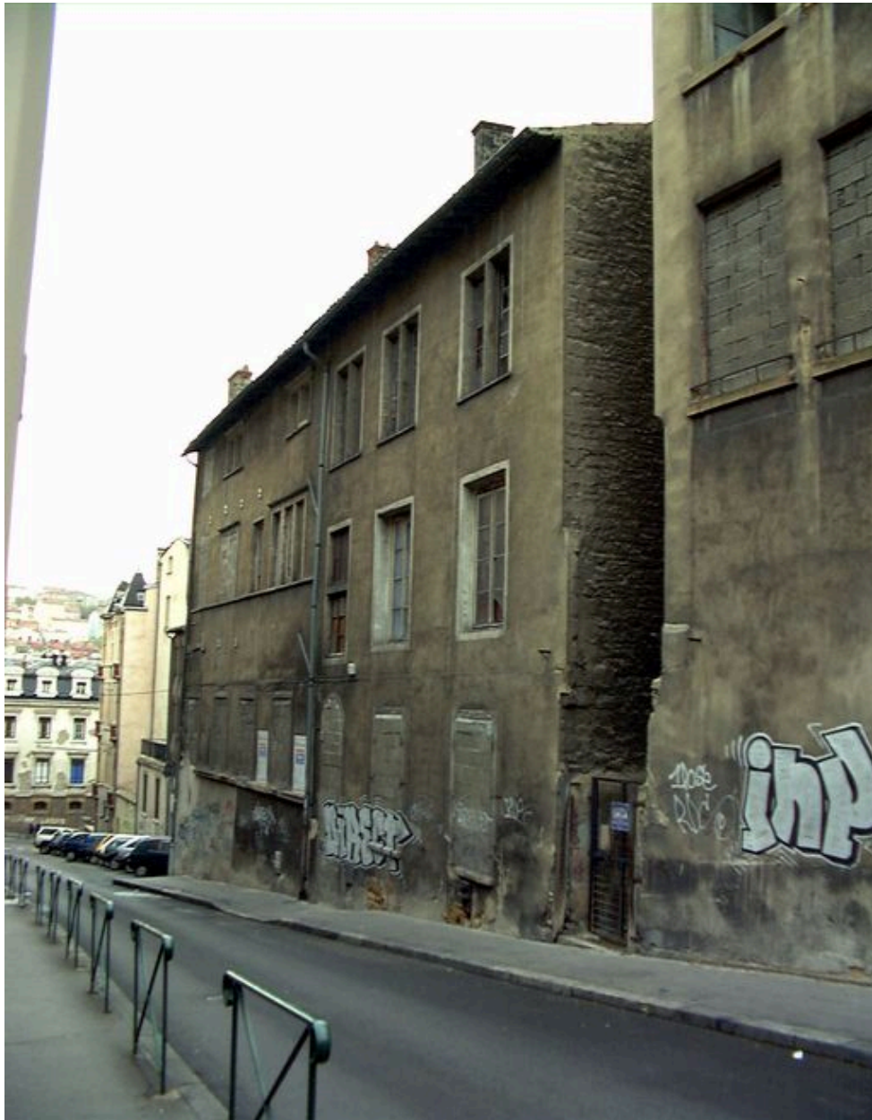
Vue générale sur rue
