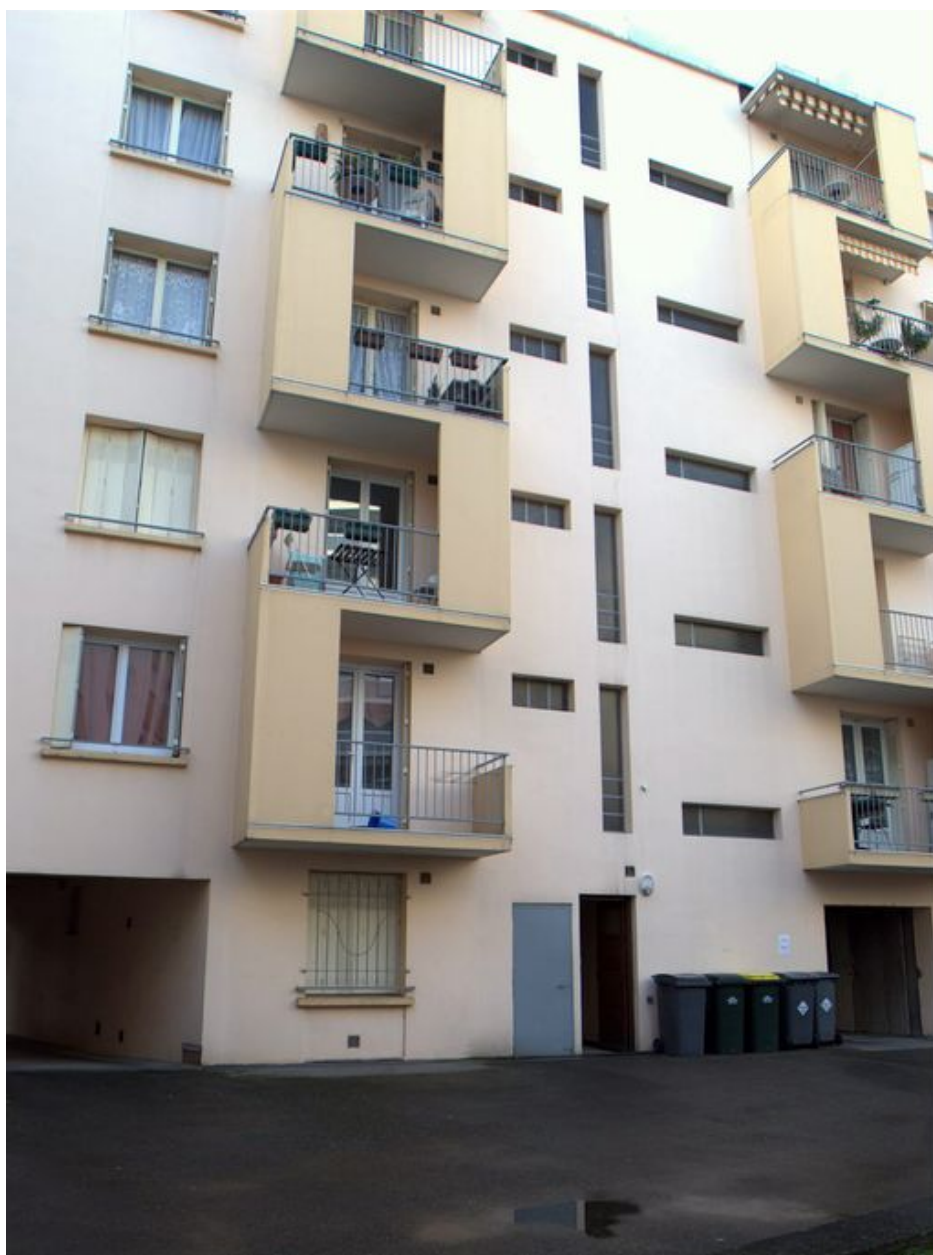
Elévation postérieure, détail des balcons
