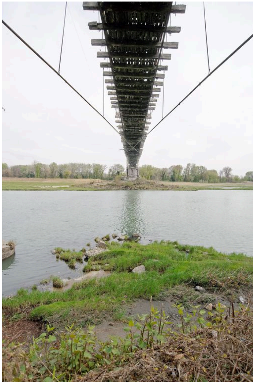
Vue du dessous du tablier (depuis la rive droite)
